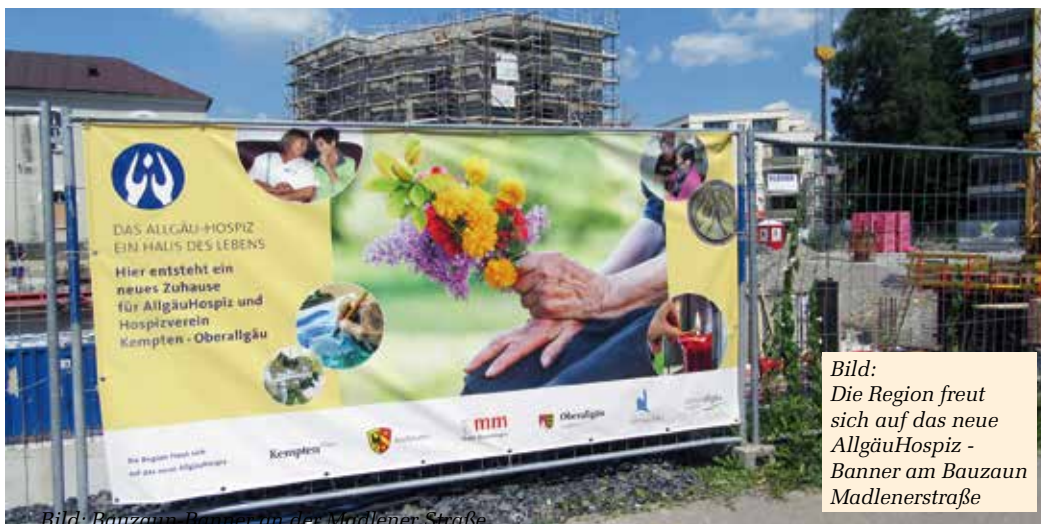
Bild: Bauzaun Baugrund in der Madlener Straße.
