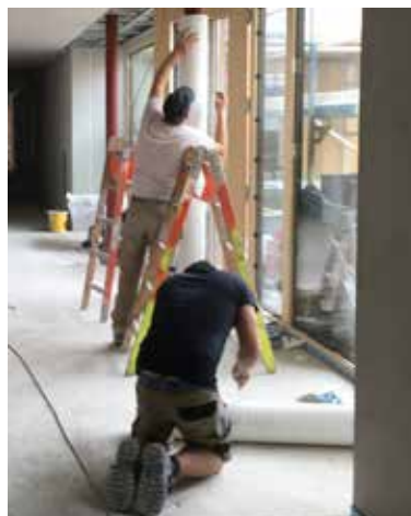
Bild oben Mitte: Innenarbeiten im Juni 2019. Foto © Stephan Walter.
