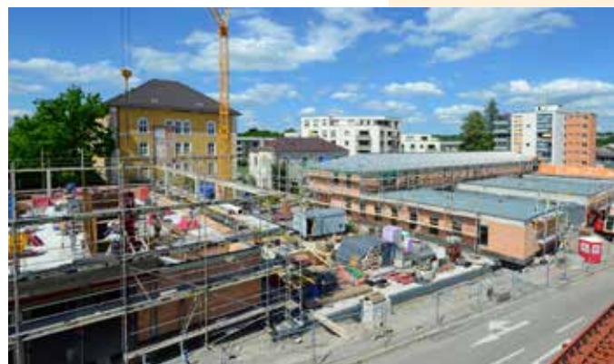
Bild oben: Blick auf das neue Hospizgebäude von der Ecke Memminger Straße / Madlener Straße. Foto: © Ralf Lienert / Sozialbau
