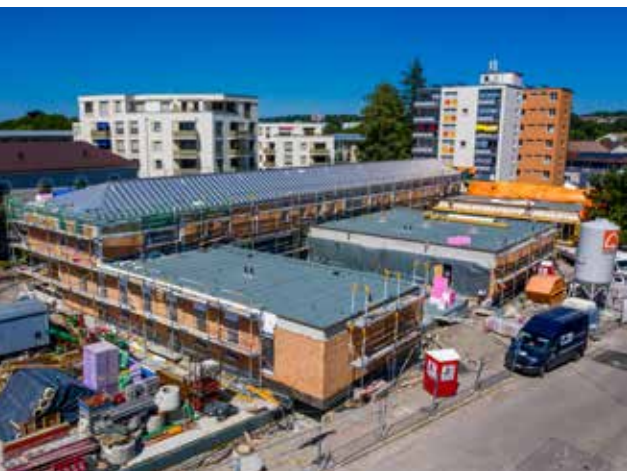
Bild oben rechts: Baustelle im Juli 2019. Foto © Ralf Lienert
